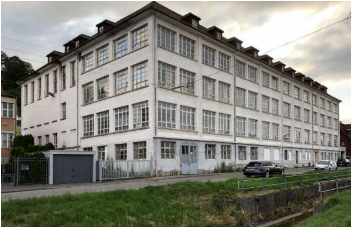
Abb. Oben: Ansicht von Südost, Aufn. Verf. 7/2023
