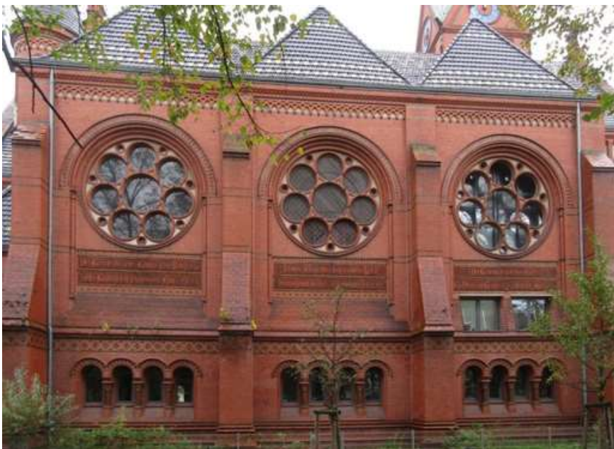
Abb. Links: Wohnen in der Luther-Kirche 11 Man beachte die Fenster hinter und unter den Rosetten.
